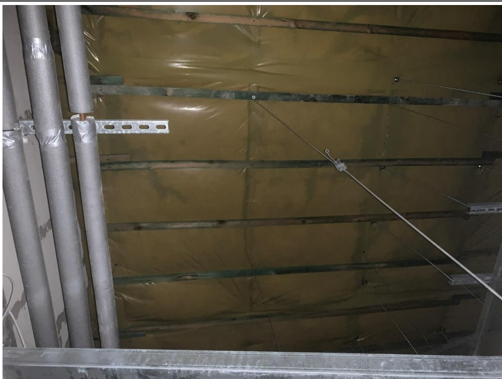
Foto nr OT.0-13 – Widok na ocieplenie dachu dwuspadowego (nad salą sprzedaży)
